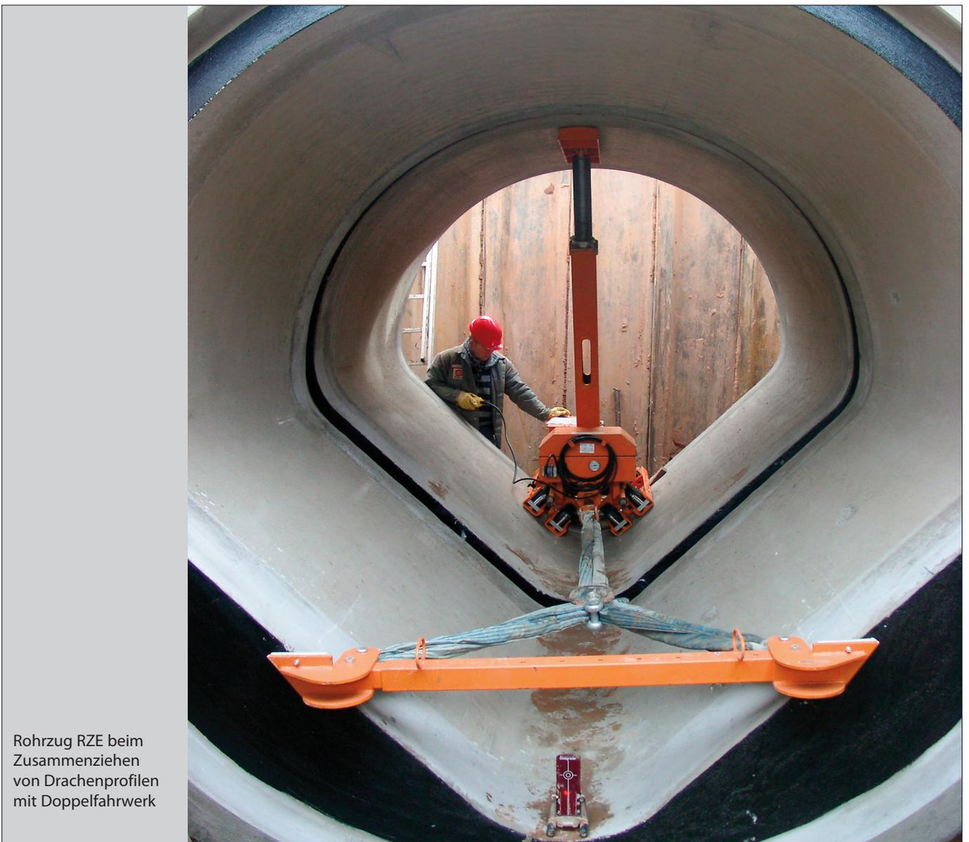
Rohrzug RZE beim Zusammenziehen von Drachenprofilen mit Doppelfahrwerk
